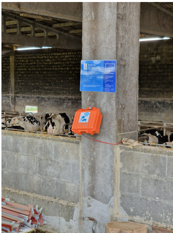
Figura 9.9: Maletín da ferramenta instalado nunha granxa para testeo.
