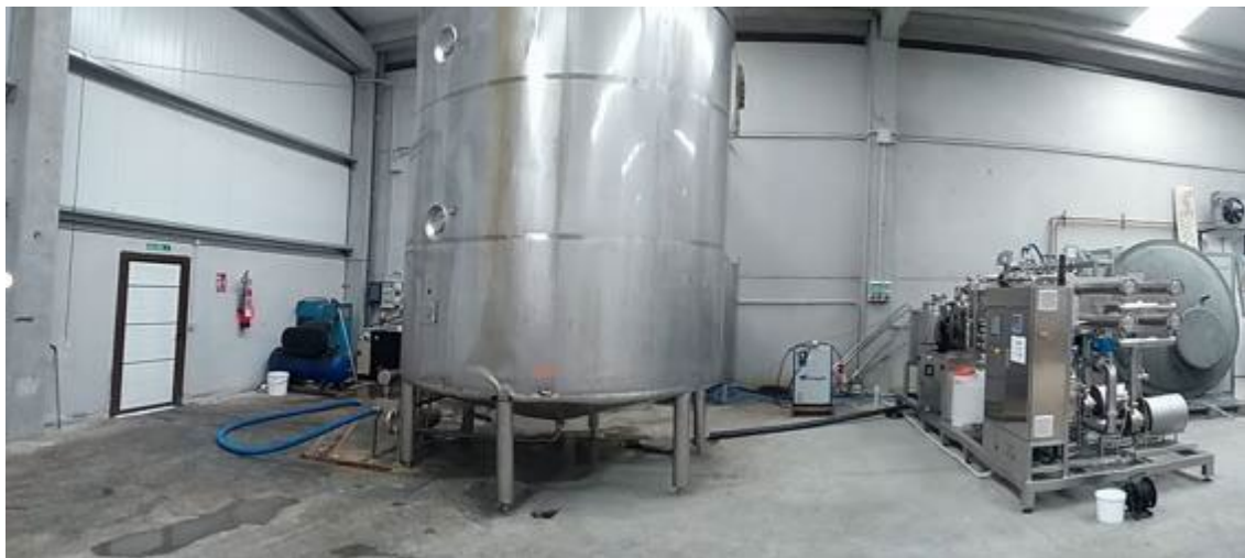
Ilustración 1 INICIO TRABAJOS PLANTA NANOFILTRACIÓN
