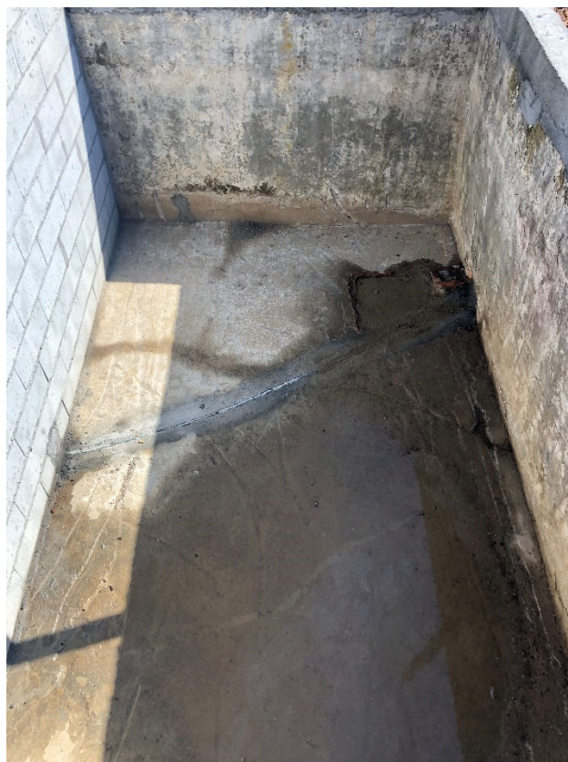
Figura 1.1.7. Nivelación para a formación de pendiente con morteiro en solera.
