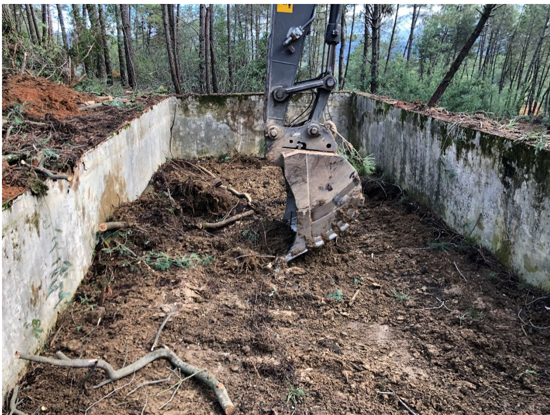
Figura 1.1.4. Limpeza interior e retirada de sedimentos
