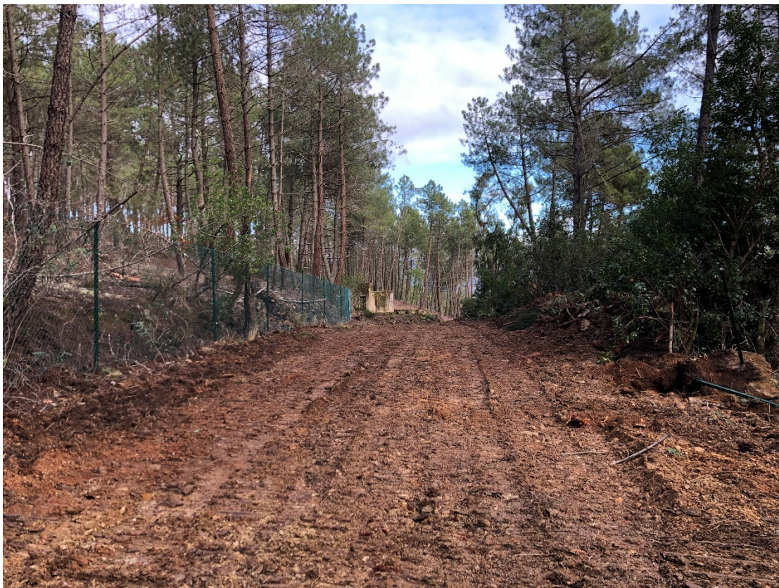
Figura 1.1.3. Compactación de zahorra na rampla de acceso
