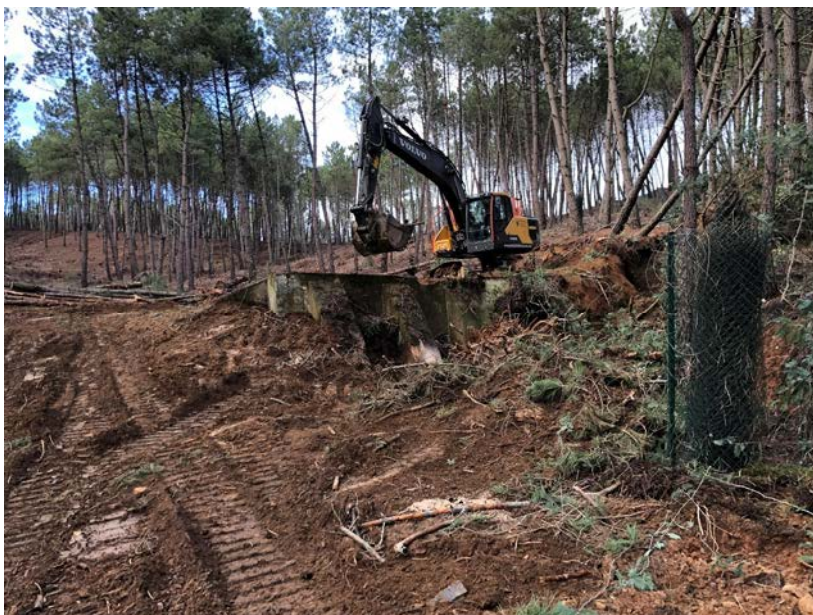
Figura 1.1.2. Retirada de tela e pilares metálicos, tala e de desbroce de maleza
