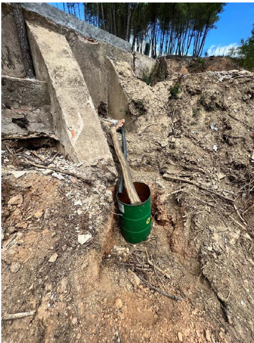
Figura 1.1.12. Colocación de depósito para a recollida de lixiviados.
