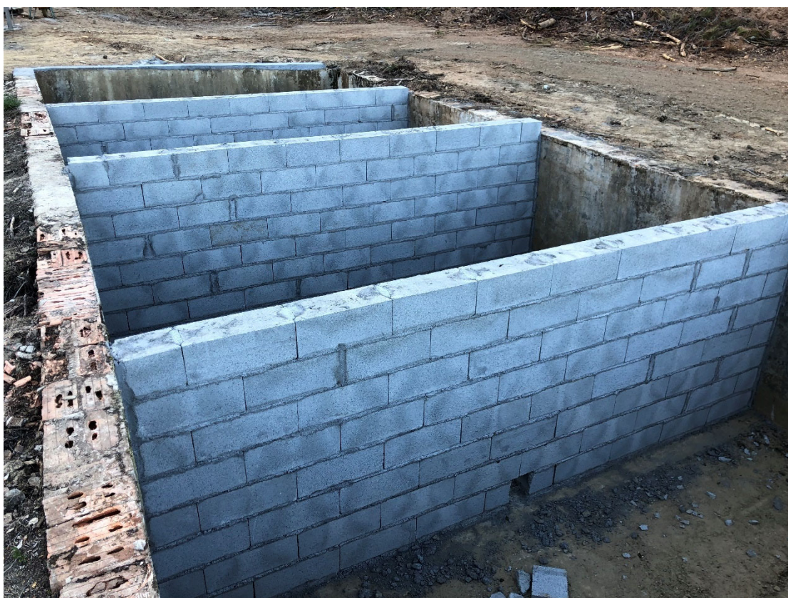
Figura 1.1.8. Compartimentación interior con bloque de formigón 20 cm.
