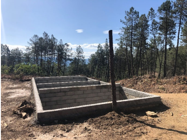
Figura 1.1.10. Colocación de soporte para tapado da balsa
