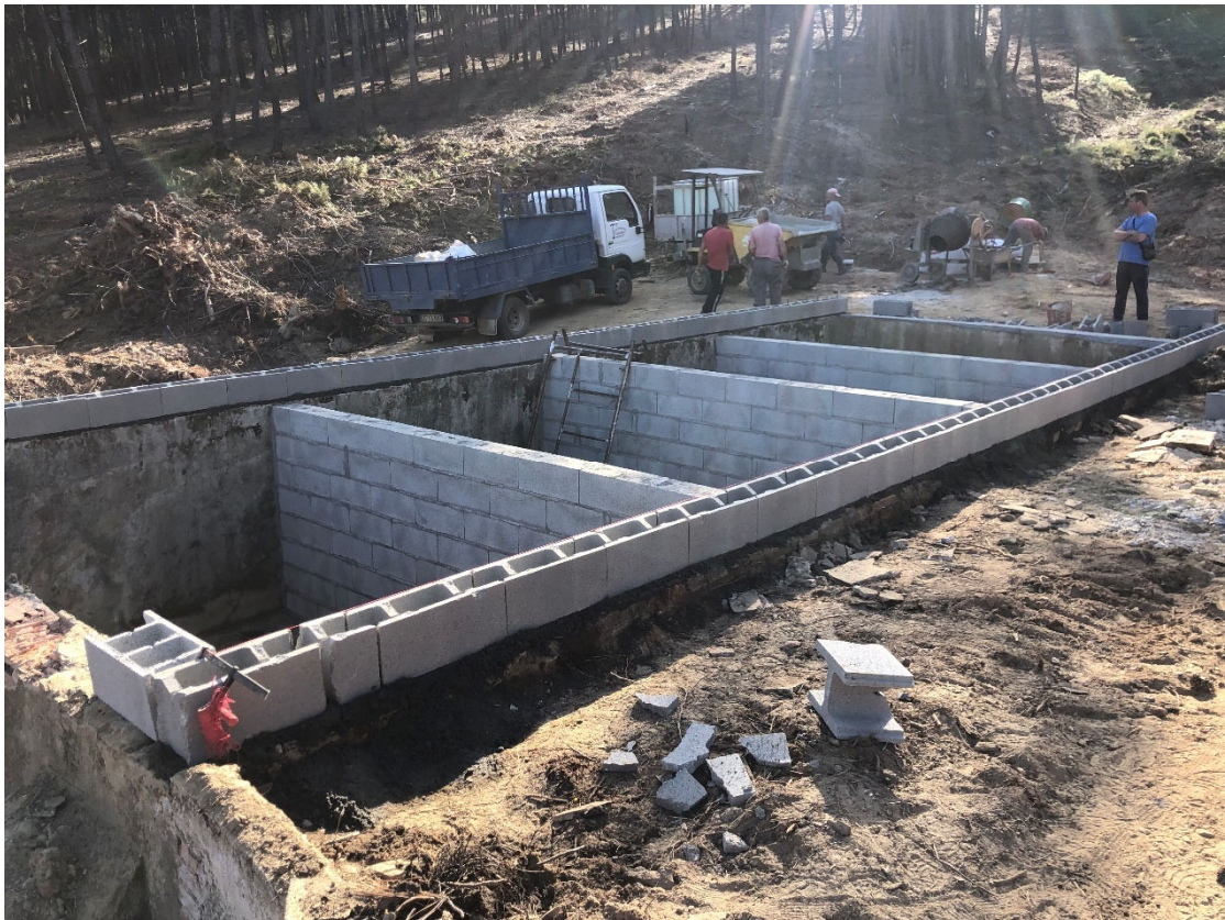
Figura 1.1.9. Recrecio de muro perimetral con bloque de formigón.
