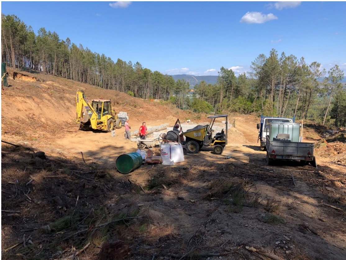
Figura 1.1.5. Apuntalamiento estructuras, selado de gretas e enfoscado
