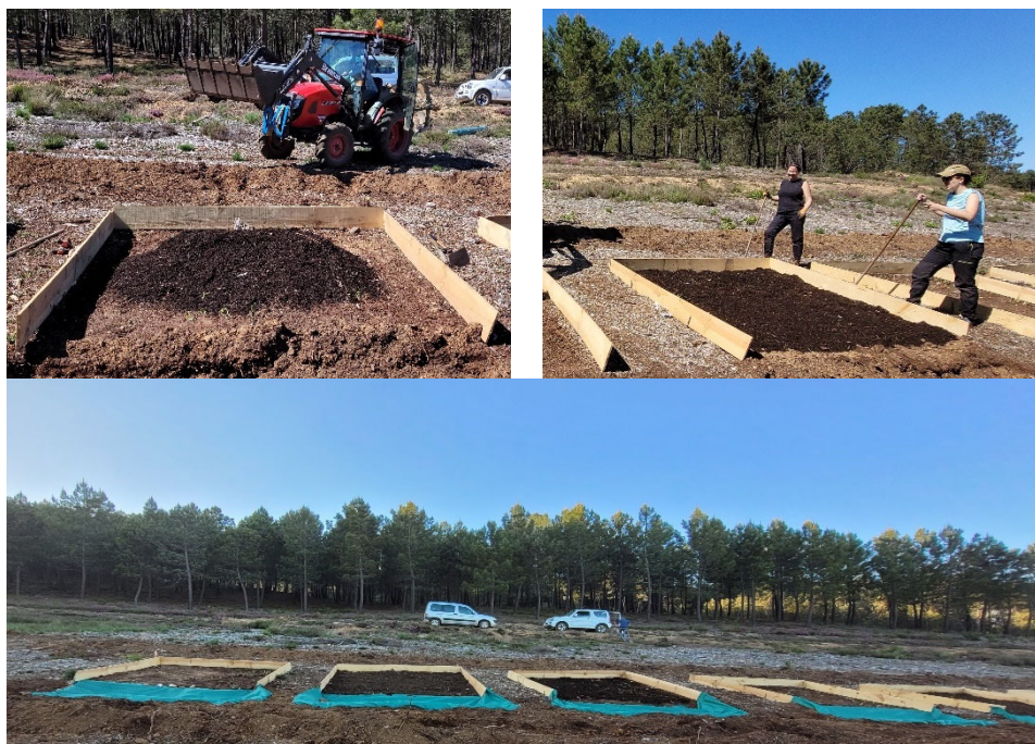
Figura 3.2.1. Fotografías do aporte e distribución de material compostado nas subparcelas da zona de cambio de uso de uso a viñedo (imaxes arriba) e aspecto xeral das subparcelas unha vez rematada a adición de material (imaxe inferior).
