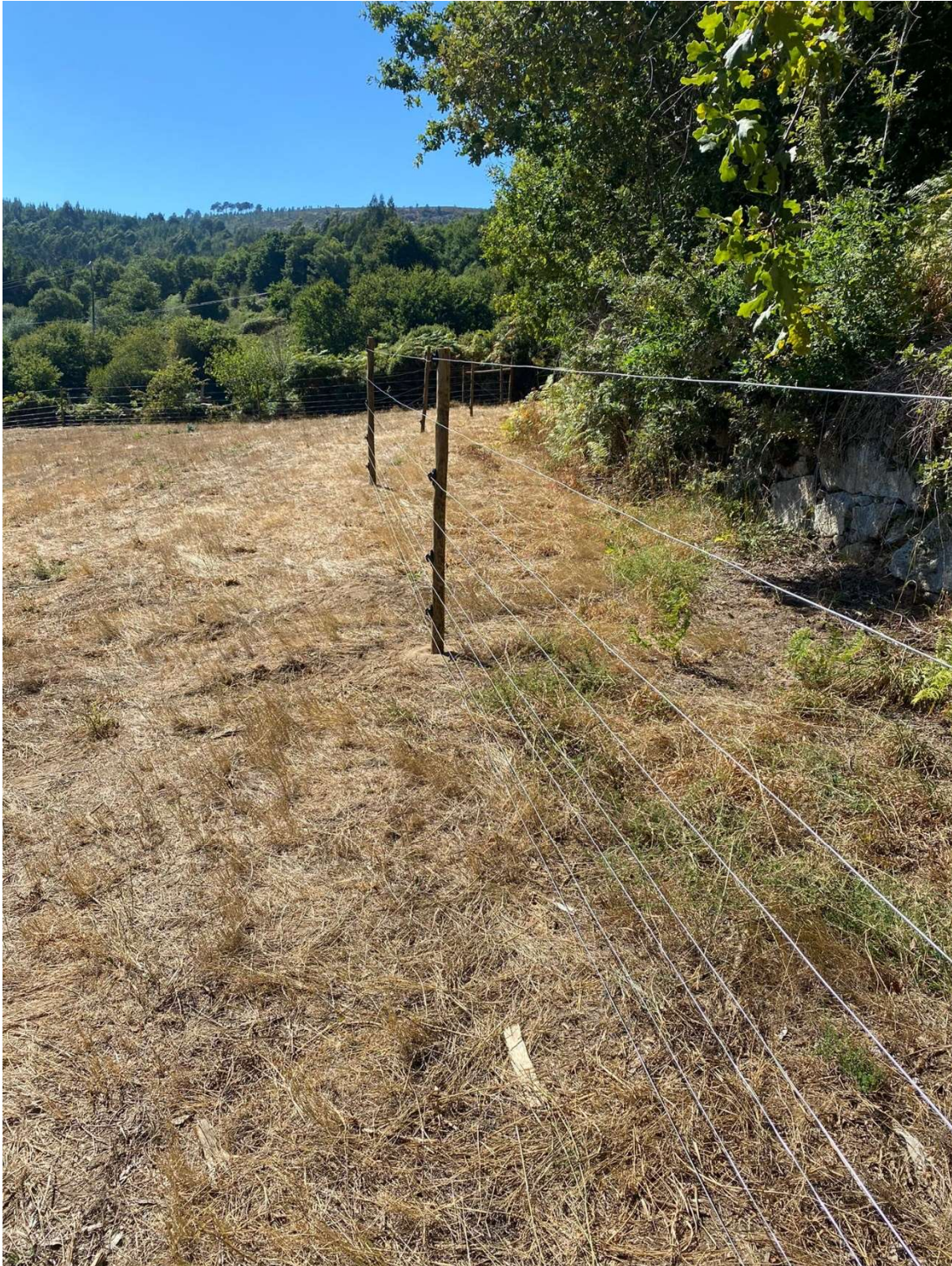
Figura 3.2.2.- Cierre de hilos instalado.
