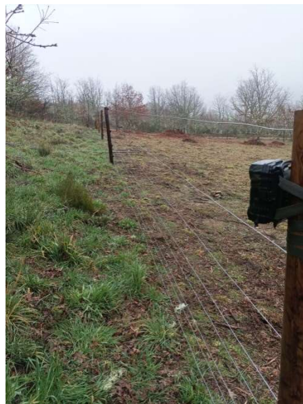
Figura 4.4.10.- Detalle de la ligera pendiente en el lateral del cierre fijo de hilos de Chandrex de Queixa
