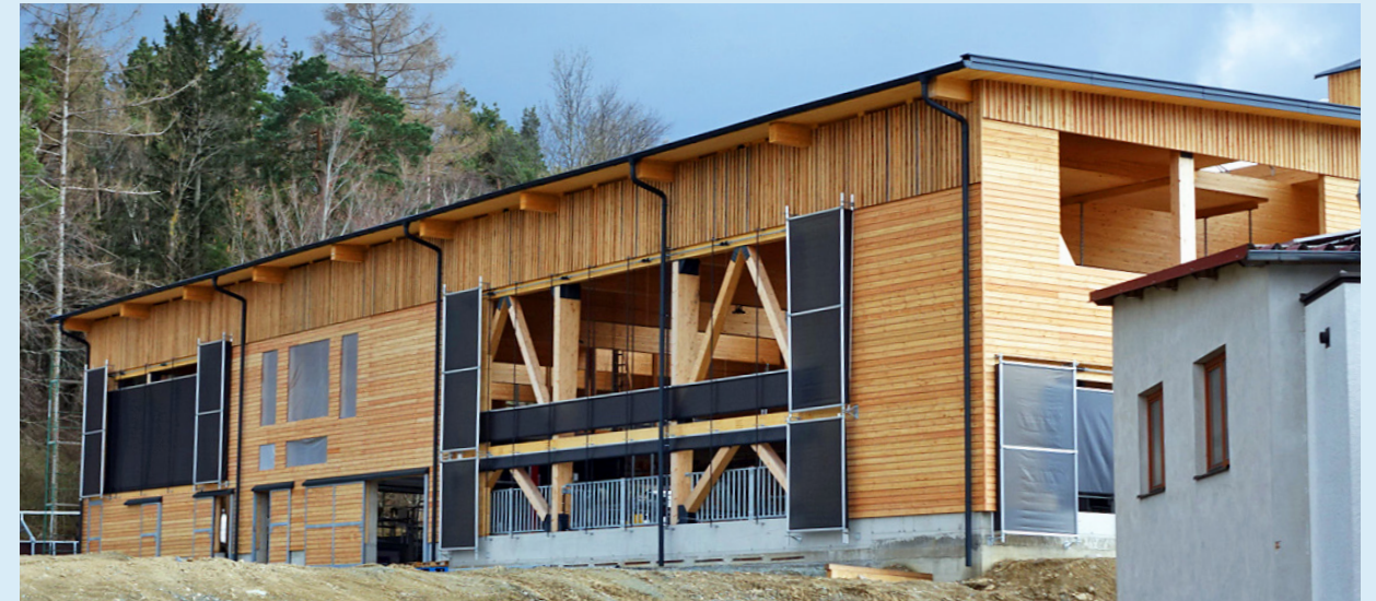
Construción da nova corte en madeira
