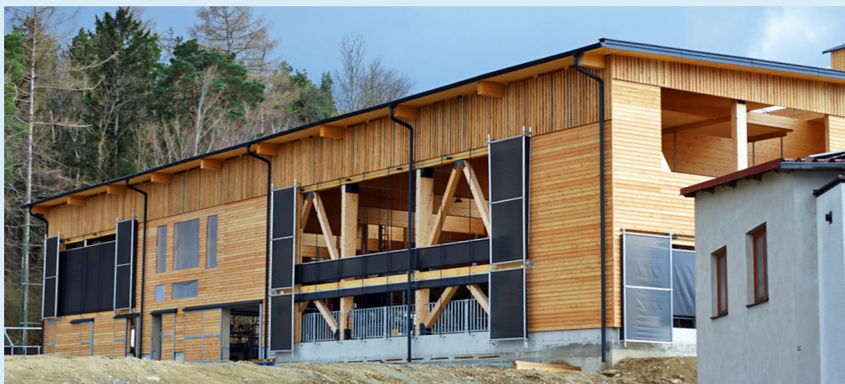
Construción da nova corte en madeira
