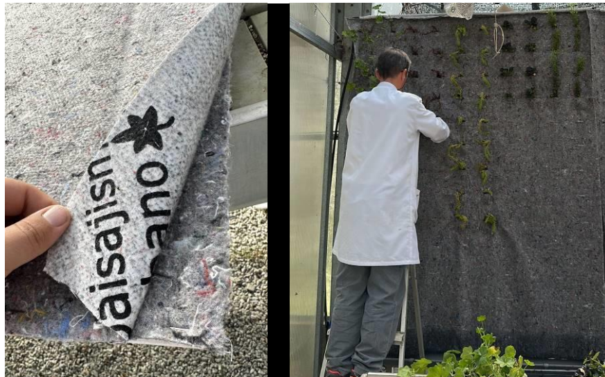
Figura 34. Sistema de tela con bolsillos, detalle de los fieltros (derecha) e instalación de las plantas con formación de los bolsillos por grapado (izquierda)
