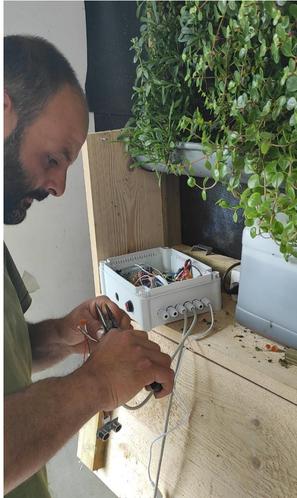
Figura 47. Instalación del prototipo final (sin caja auxiliar de conexiones) (2)
