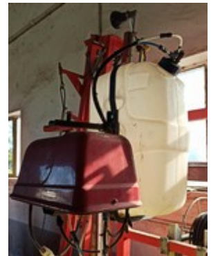
Ilustración 31. Depósito de espuma
