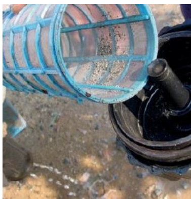
Ilustración 6: Limpeza de filtro de mallas
