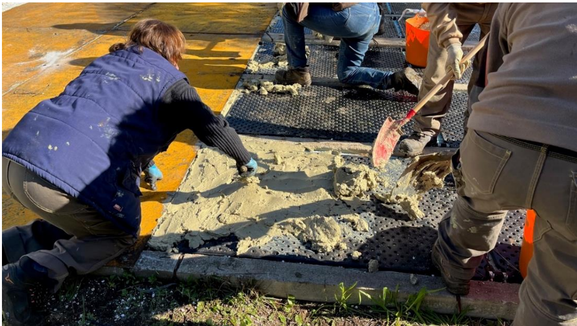
Figura 10: Aplicación de bentonita sódica sobre os paneis solares antes da colocación das chapas de aceiro.
