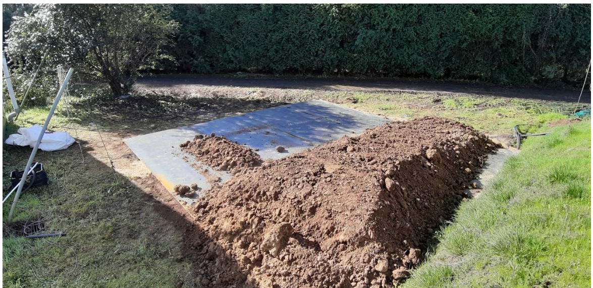
Figura 8: Tubarias cubertas coas chapas de aceiro e inicio da carga da pilla de esterco.
