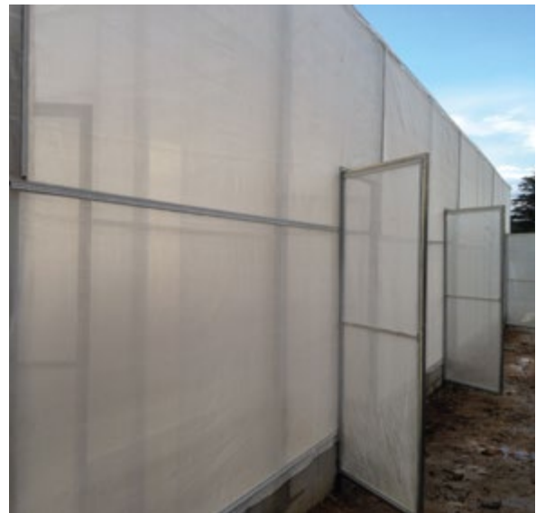
Vista exterior do sistema de dobre porta
