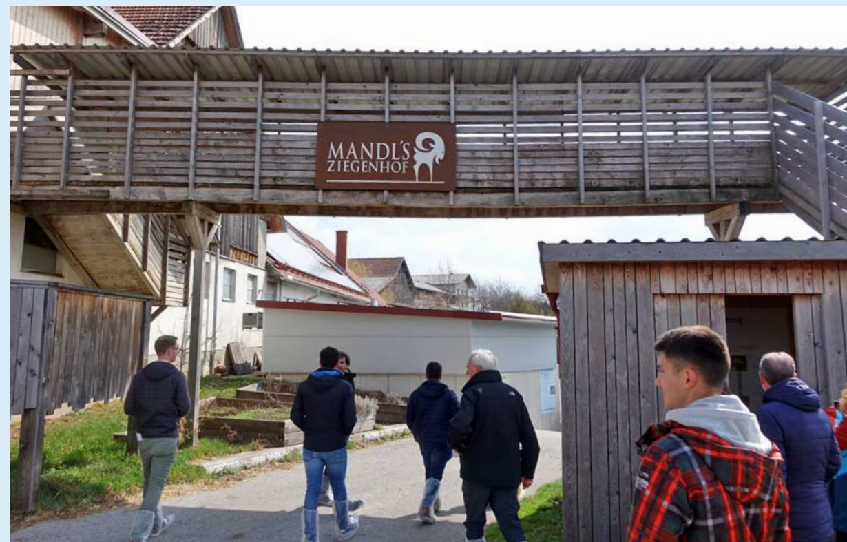
Paso elevado para cabras na granxa ecolóxica Mands
