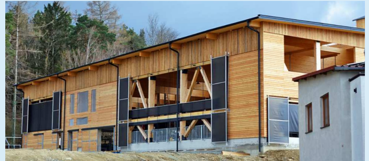
Construción da nova corte en madeira
