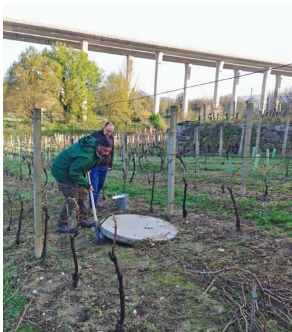
Recollida de augas no pozo do viñado
